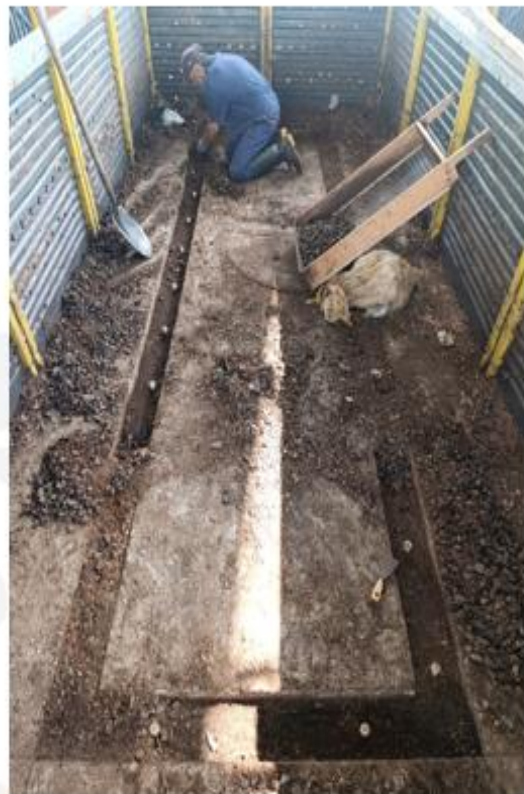
Acondicionamiento Puesta en Marcha y
