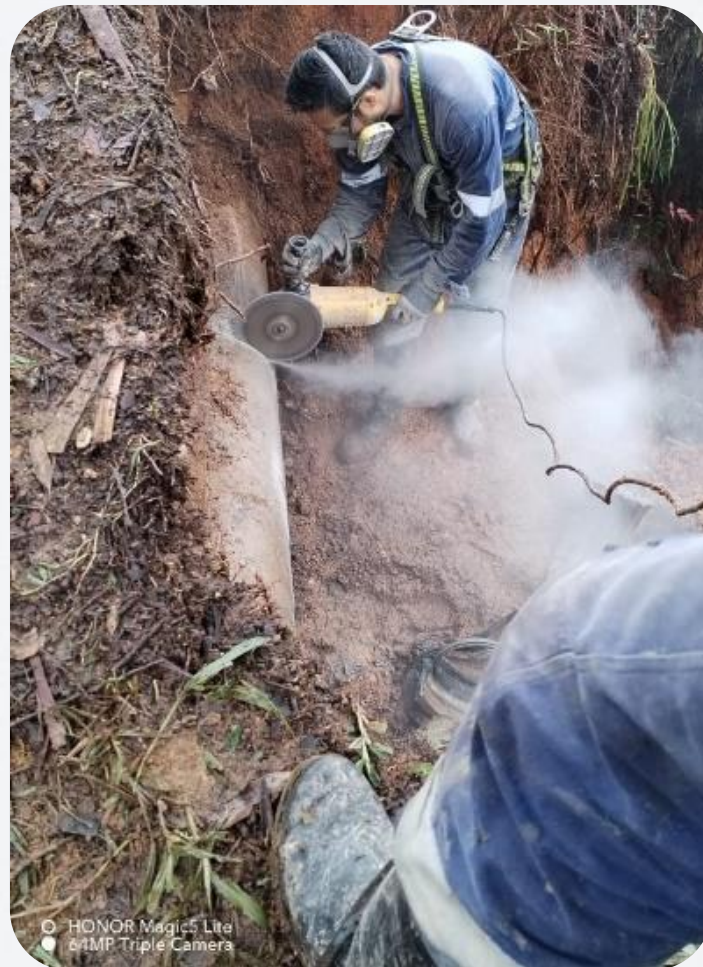
Reparación aducción No. 01
