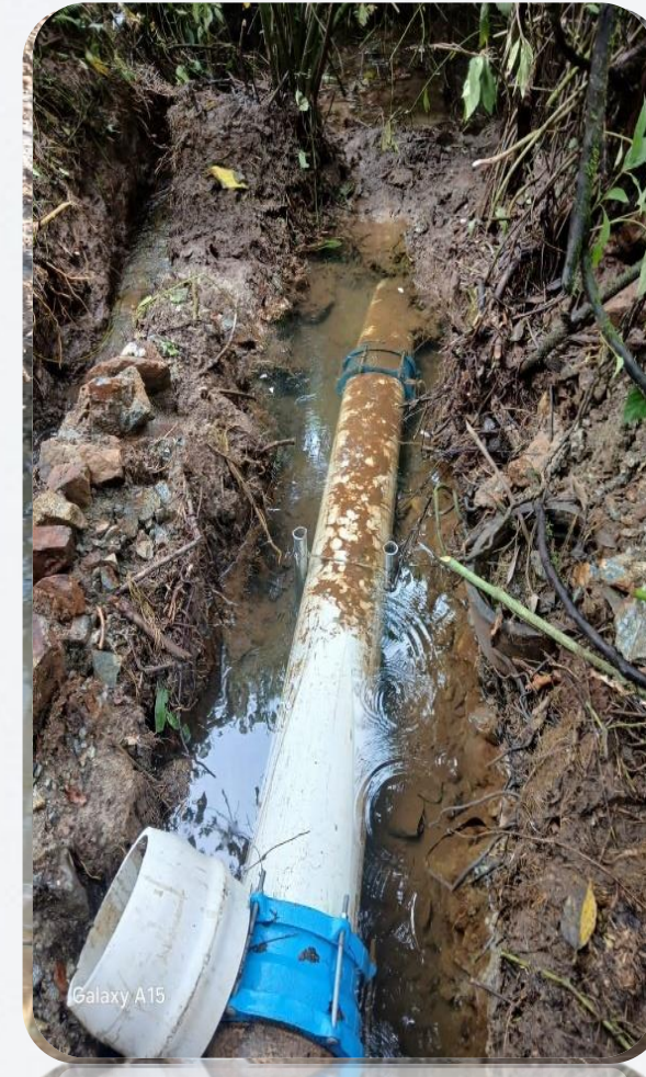
Reparación aducción No. 02
