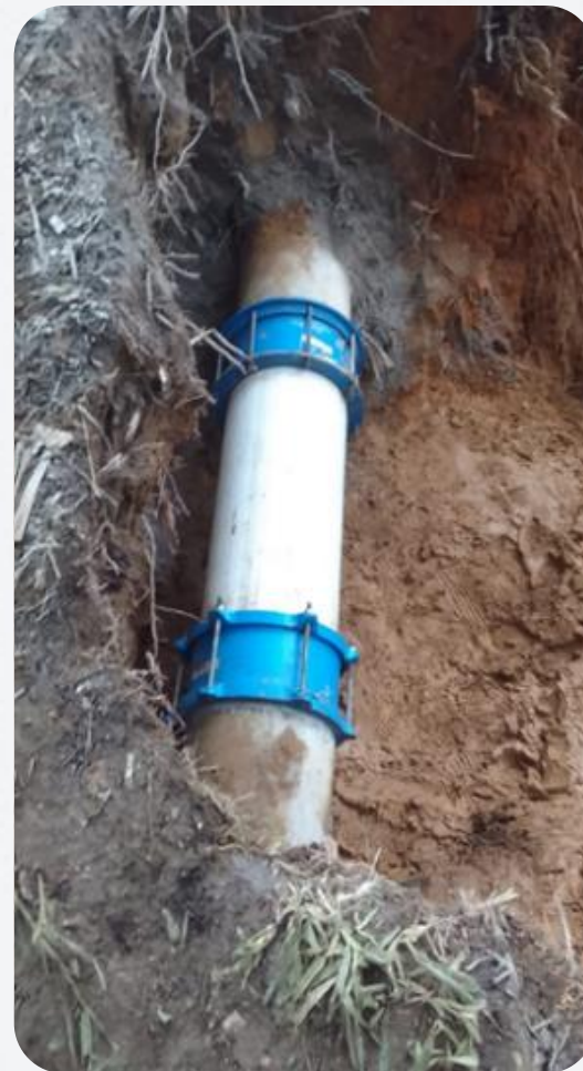
Tubería reparada No. 01
