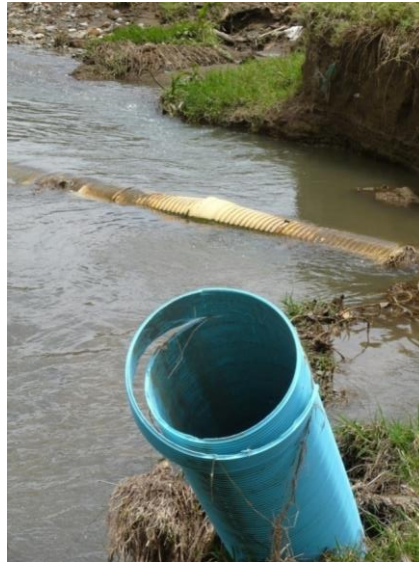
Quebrada San Roque. Colapso del Interceptor en Tubería PVC NOVALOC y NOVAFORT.
