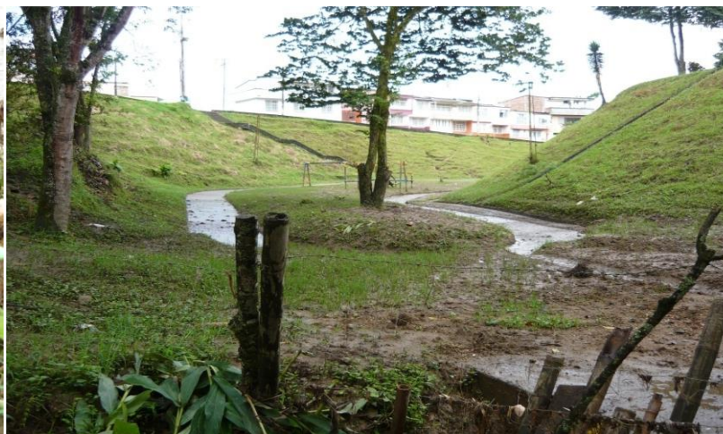
Reboce de cámara. Arrastre de material de avalancha
