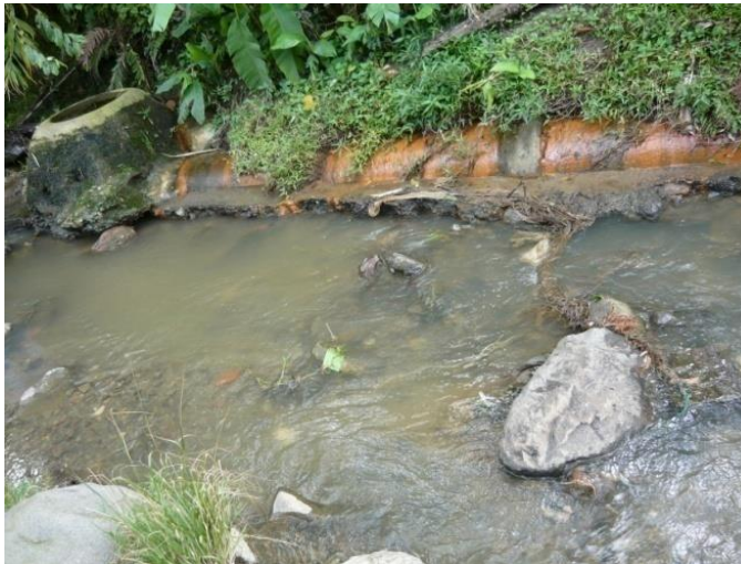
Interceptor paralelo a la Quebrada La Italia.
