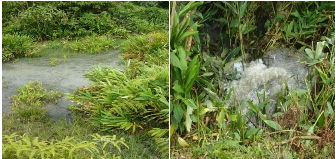
Reboce cámara Quebrada La Italia a la altura del Barrio Bosques de Santa Ana 2ª. Etapa.
