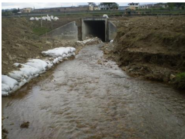
Foto 1. San Roque Box Culvert
