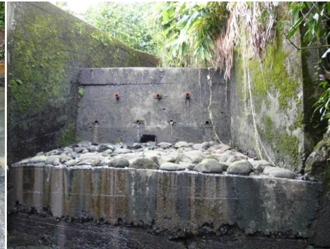
Estructura de aliviadero Quebrada La Italia.
