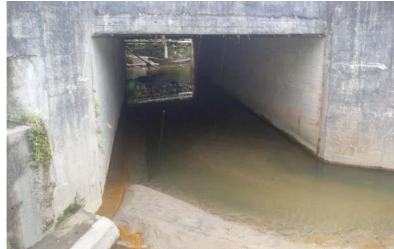
Box culvert cruce vía.
