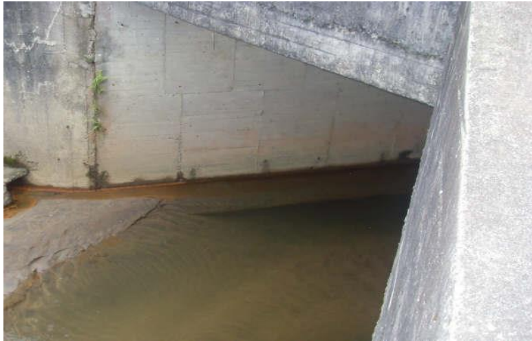
Punto de vertimiento. Box culvert cruce vía.
