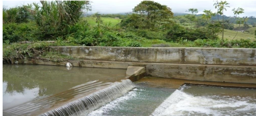
Quebrada San Roque. Obras de Cruce y trasvase de sentido de quebrada en perfecto estado.
