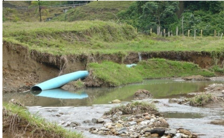
Quebrada San Roque. Colapso del Interceptor en Tubería PVC NOVALOC y NOVAFORT.
