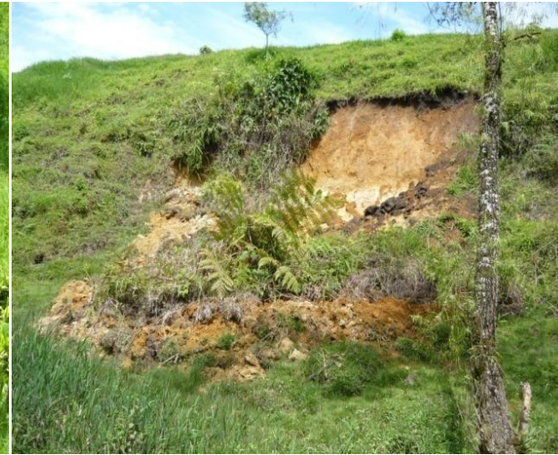
Erosión talud lateral colector barrio Álamos.
