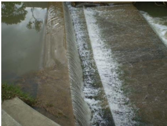
Foto 1. Quebrada San Roque disipador de velocidad
