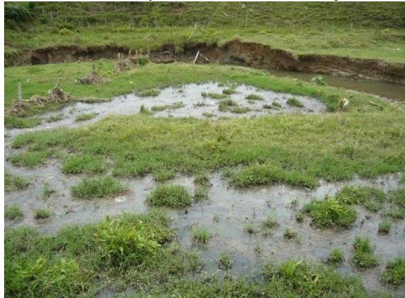
Q. San Roque. Colmatación de Cámara
