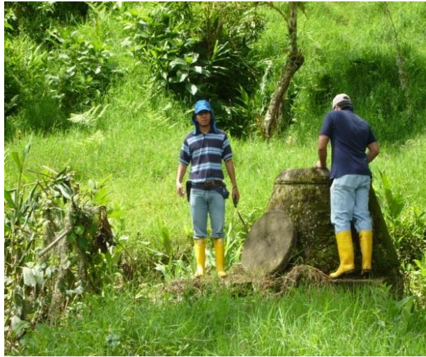
Cámara Barrio Los Andes – laureles – Colector Álamos.
