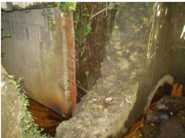
Foto 1. Caño las Lavanderas
