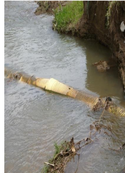
Quebrada San Roque. Colapso del Interceptor en Tubería PVC NOVALOC y NOVAFORT.
