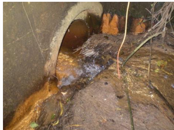
Foto 2. Canalización del Caño
