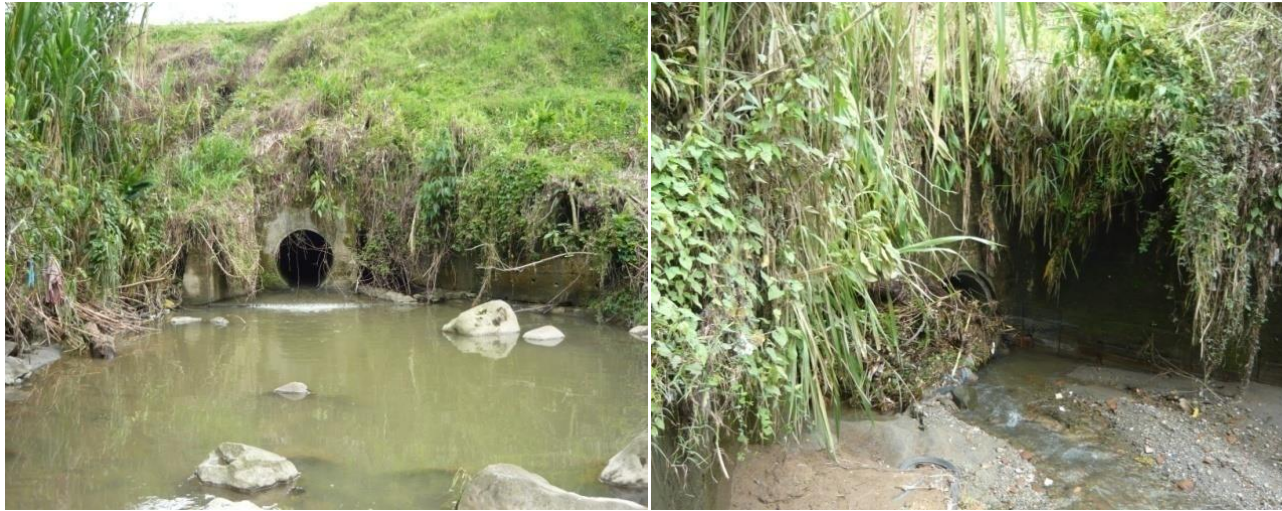
Taponamiento Interceptor Paralelo a la Quebrada La Italia a la altura del Barrio La Flora Calle 22
