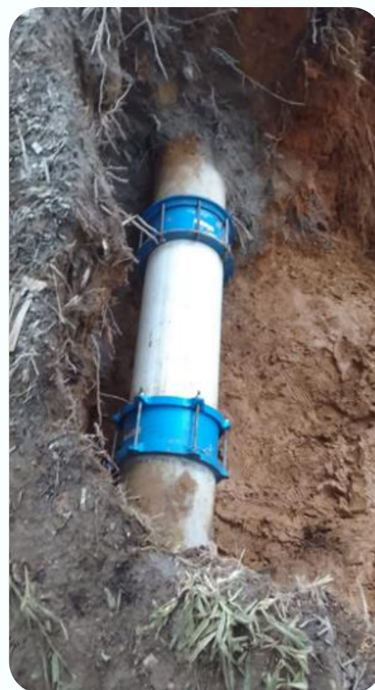
Tubería reparada No. 01
