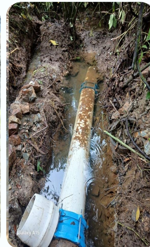
Reparación aducción No. 02
