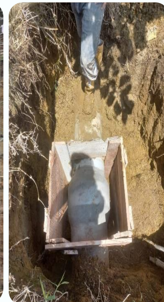
Tubería reparada No. 02
