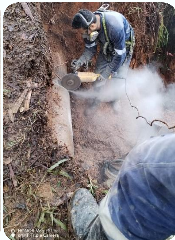
Reparación aducción No. 01
