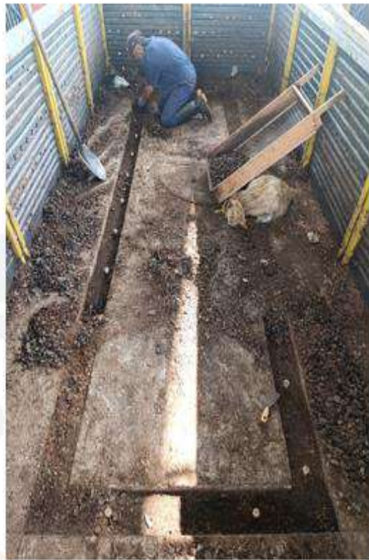
Acondicionamiento Puesta en Marcha y
